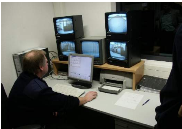
Fotografia nr 4.19. Obsługa komory mimo zadymienia obserwuje ćwiczących
