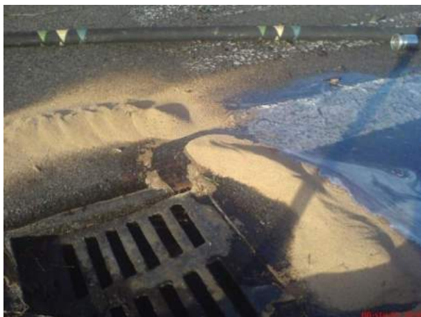
Fotografia nr 12.8. Zabezpieczenie studzienki sorbentem
